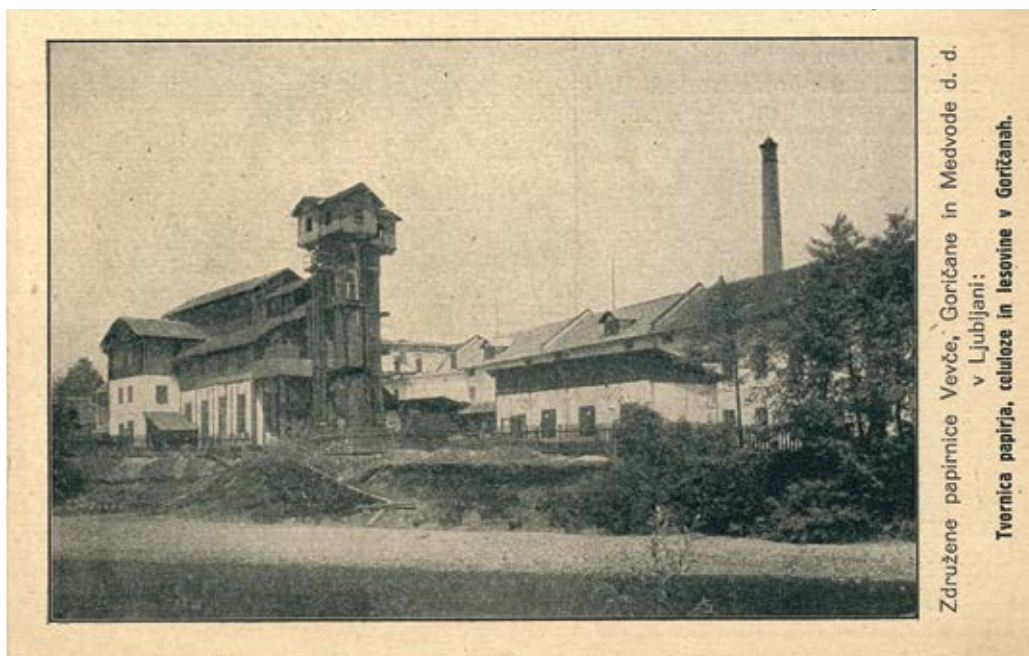
Fotografija proizvodnje celuloze na »otoku« med reko Soro in turbinskim kanalom iz leta 1923.
