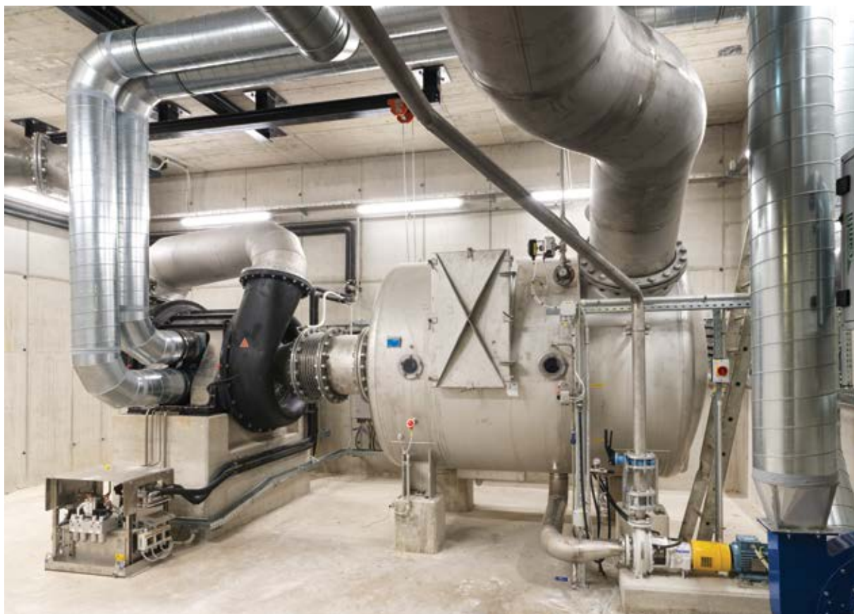
Nov vakuumski sistem RunEco podjetja Runtech, ki vključuje turbo puhalnik EP600 ter ločilnika vode EcoDrop in EcoSep.
