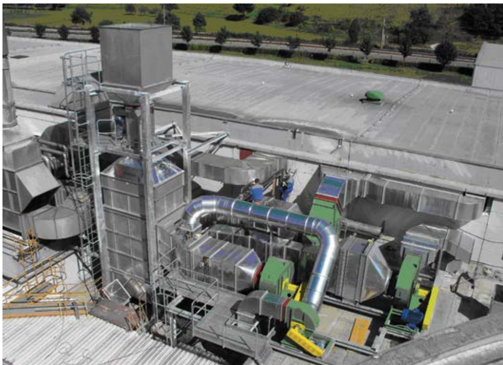
Modernizacija rekuperacije odpadnega zraka.
