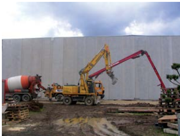
Gradnja novega skladišča
