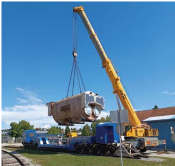
Rezervni parni kotel Loos
